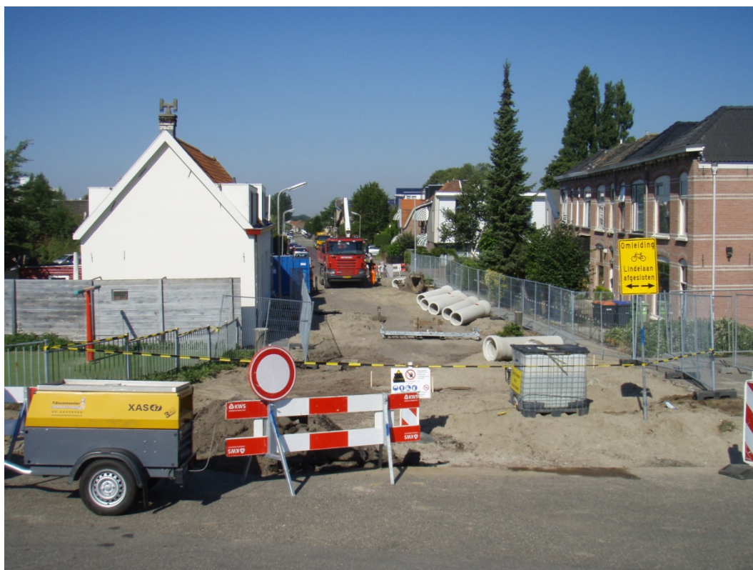
Afb. 2. Onderzoeksgebied vóór aanvang van de werkzaamheden.
